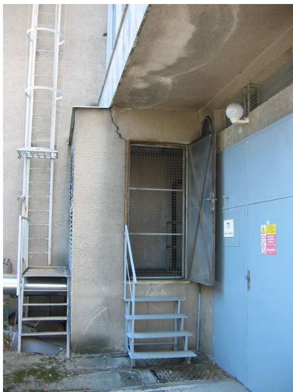
Foto 4 Narušení přístavku strojovny – jižní fasáda, nespolehlivé založení
