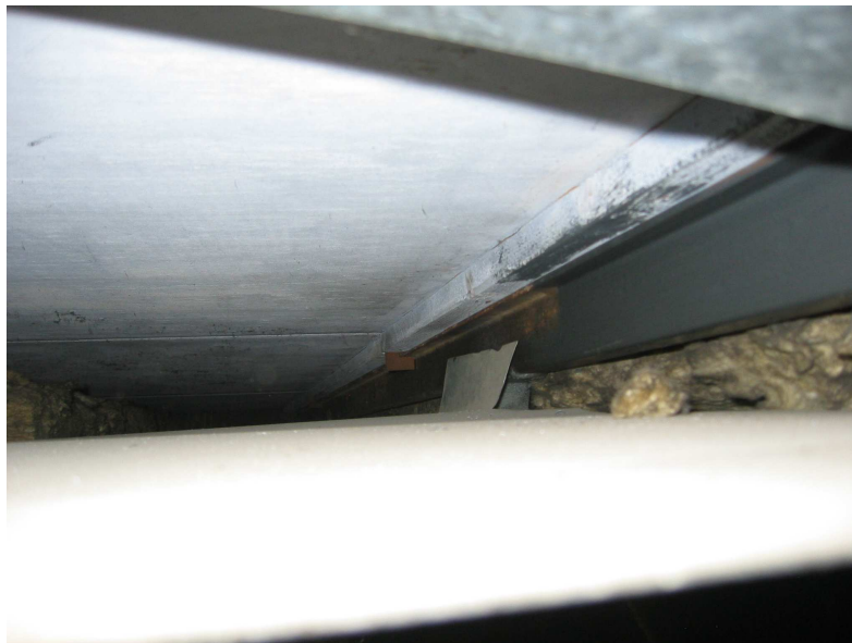
Foto 39 Původní skladba střešního pláště – izolační desky JRD Nemšová
