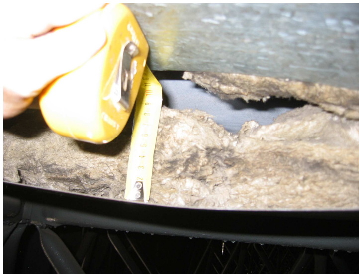
Foto 40 Sonda do dodatečného zateplení střešního pláště
