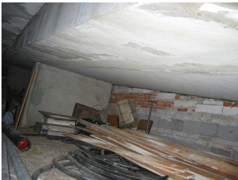
Foto 46 Spodní povrch rampy – mapy po pronikání vlhkosti s povrchu rampy
