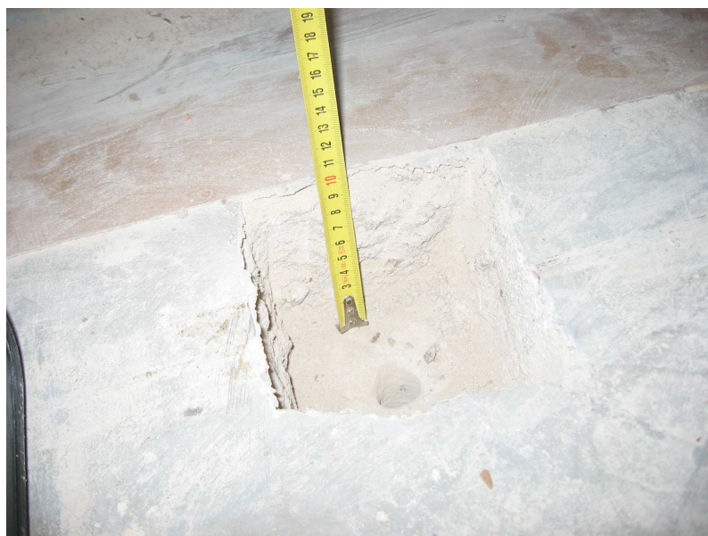
Foto 22 Sonda do podlahy 1. NP v místě nad přístavkem
