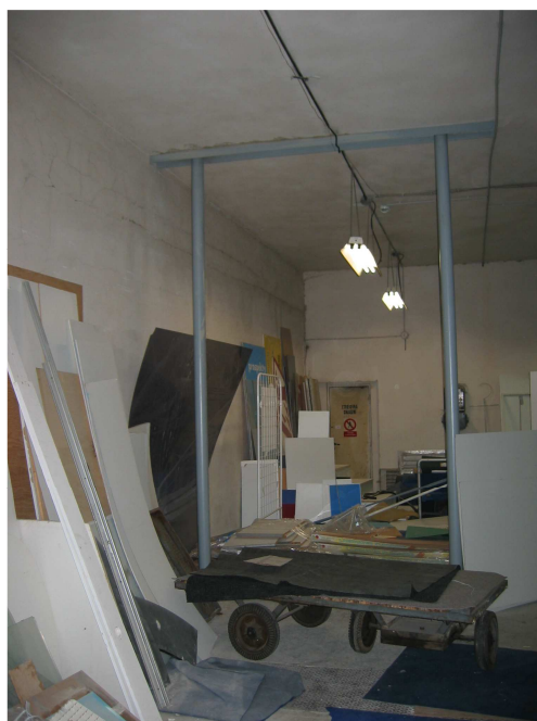
Foto 12 Podepření stropní konstrukce – souvislost s výměnou eskalátoru
