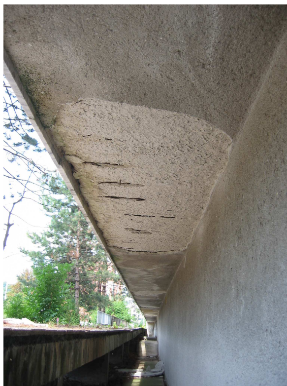
Foto 5 Koroze výztuže a degradace omítky konzoly
