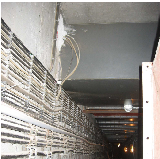
Foto 30 VZT potrubí vstupující s kolektoru pod výstavní plochou směrem do vstupního objektu pavilonu severním směrem
