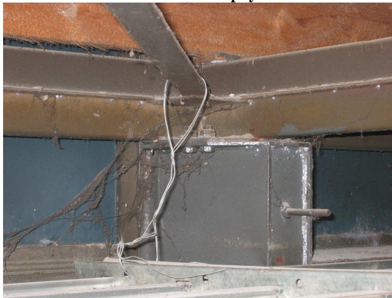
Foto 32 Uchycení obvodového sloupku ke kyvné stojce střechy – 4xM10
