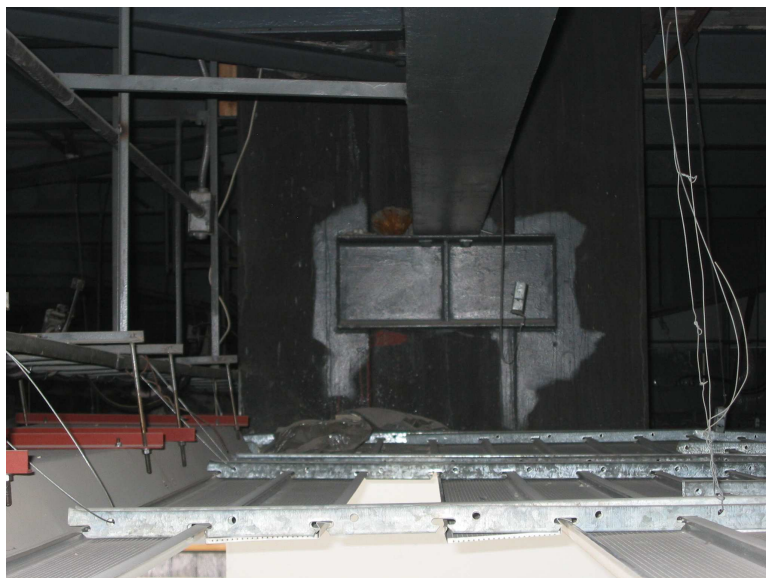
Foto 19 Uložení OK průvlaků galerie je provedeno také na konzolu hlavního sloupu střechny
