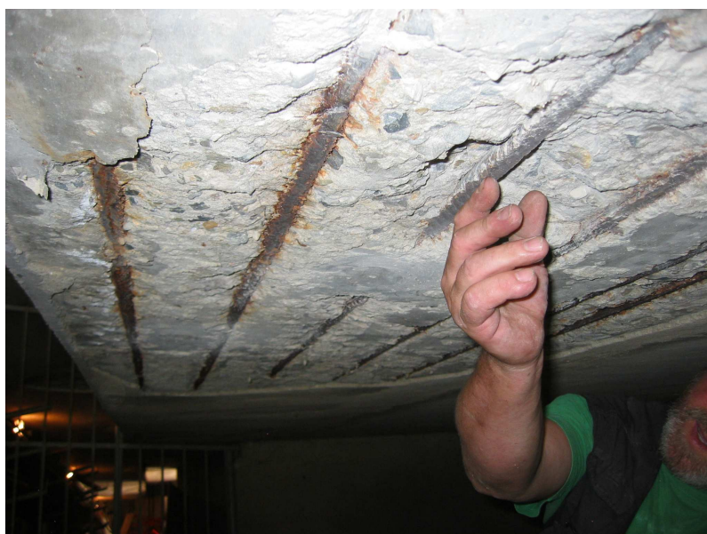
Foto 47 Koroze výztuže rampy
