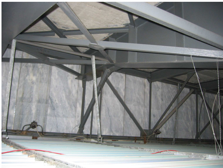
Foto 18 Sonda do stropní konstrukce galerie – ocelová konstrukce + PZD desky
