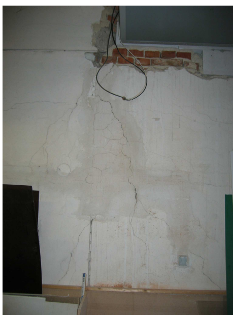
Foto 10 Poruchy zdiva mezi místností č. 45 a kolektorem – stavení úpravy při výměně eskalátoru
