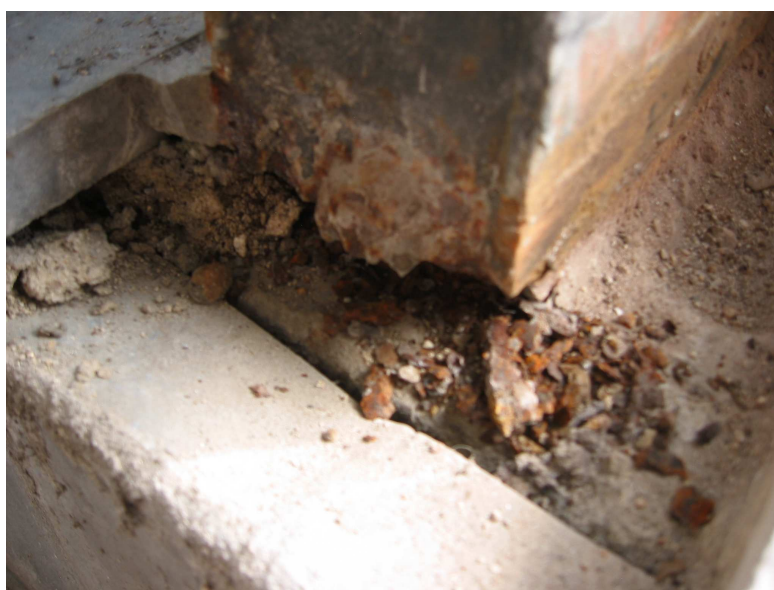
Foto 36 Detail koroze – spodní pata sloupku zaplněna korozními zplodinami dutého průřezu
