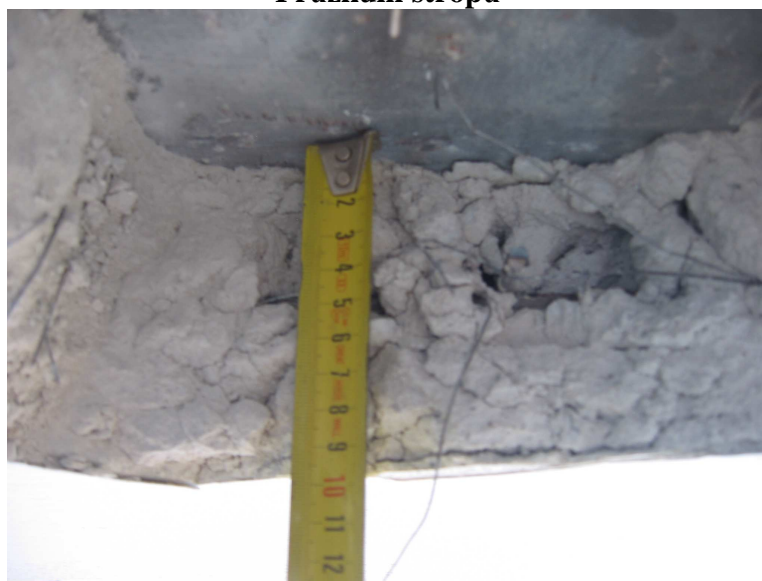
Foto 16 Hlavní sloup je krytí omítkou vyztuženou síťovinou tl. 90 mm
