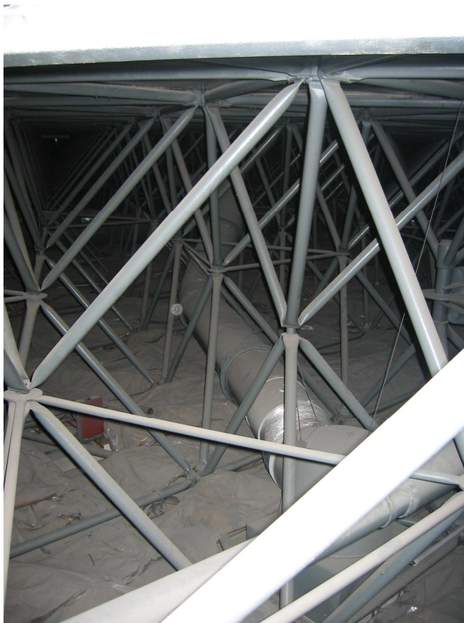
Foto 41 Pohled na prostorovou příhradovou konstrukci hlavní střechy
