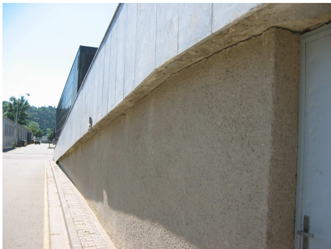
Foto 44 Podezdívka rampy – sedání základu, zdivo nesouvisí se statikou rampy – rapa samostatně vynášena pilíři cca v ose rampy
