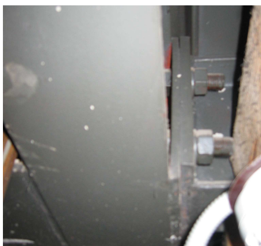
Foto 27 Připoj stropnice a průvlaku stropní konstrukce 1. NP – kancelářský přístavek
