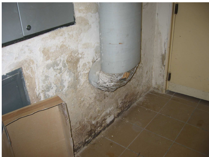
Foto 11 Vlhkost suterénu přístavku – v okolí prostupů technologie - kondenzace
