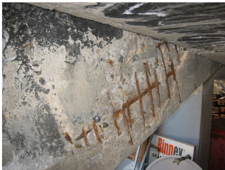
Foto 49 Stav nosných šikmých železobetonových nosníků schodiště – značná koroze
