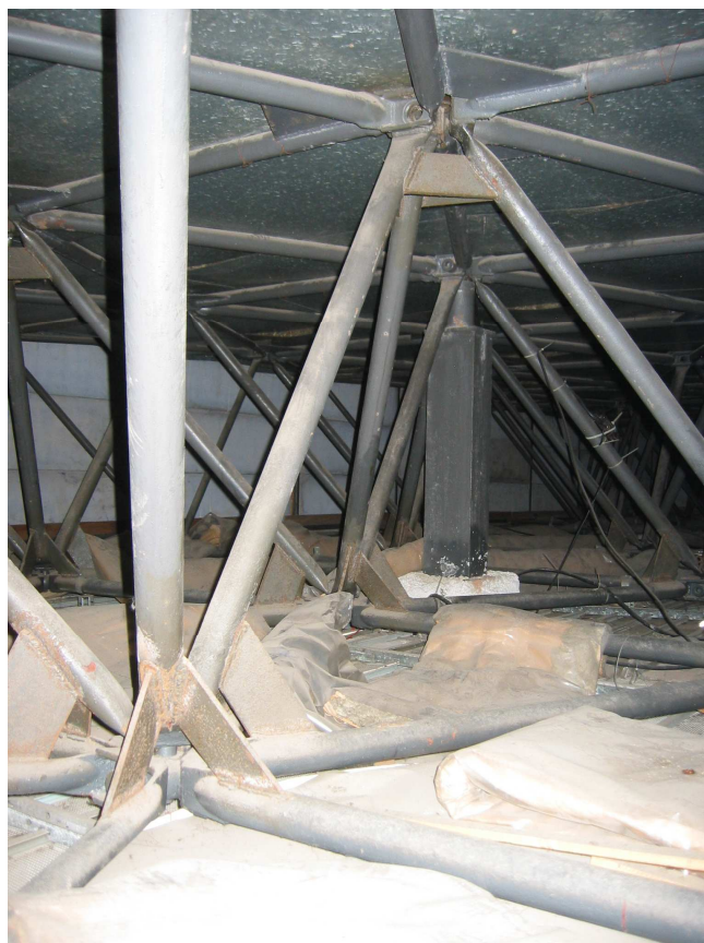
Foto 42 Pohled na střešní konstrukci vedlejšího vstupního objektu – prostorová příhradovina vynášená 2 ks ocelových sloupků
