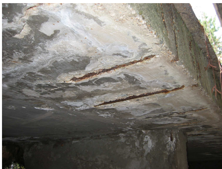
Foto 56 Koroze krajní výztuže obslužné lávky
