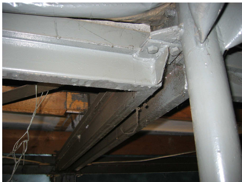
Foto 33 Kyvná stojka zabezpečující sloupek obvodového pláště ve vodorovném směru
