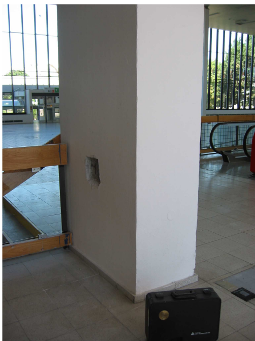
Foto 17 Sonda do hlavního sloupu nesoucího střechnu – sloup ze silnostěnných ocelových plechů
