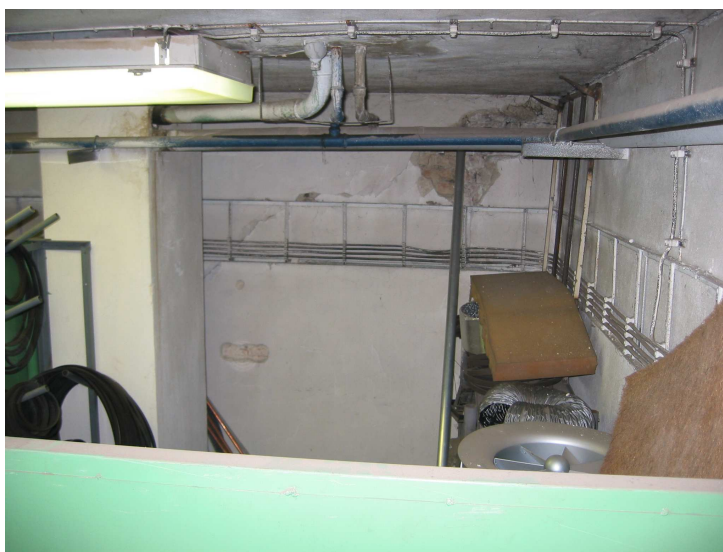
Foto 15 Narušené obvodové zdivo v místnosti č. 47 – sedání vnějšího rohu v modulu „G19“
