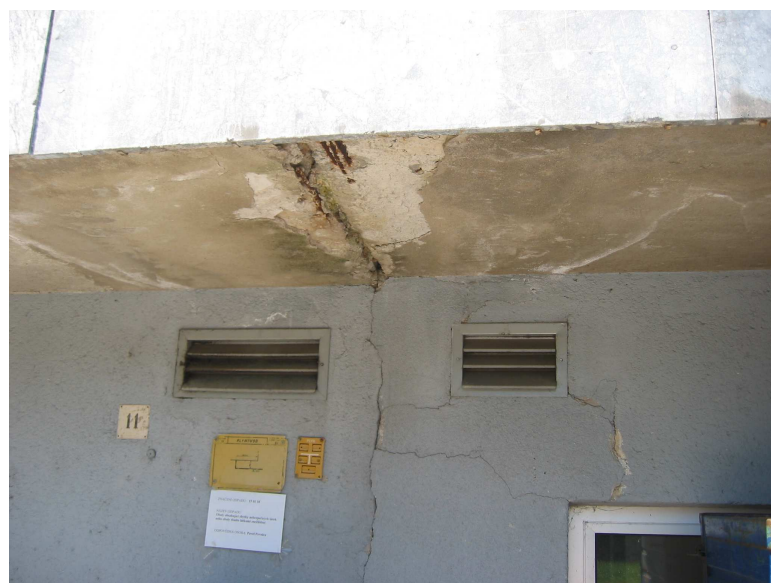
Foto 3 Poruchy v okolí dilatační spáry - modulová osa „7“ – „8“
