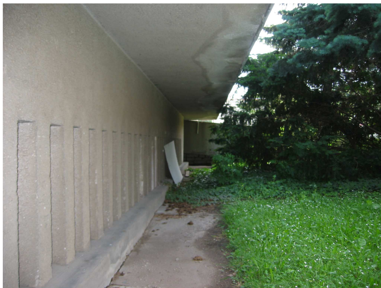
Foto 2 Konzola obvodového pláště – zatékání z pláště, degradace omítky a výztuže
