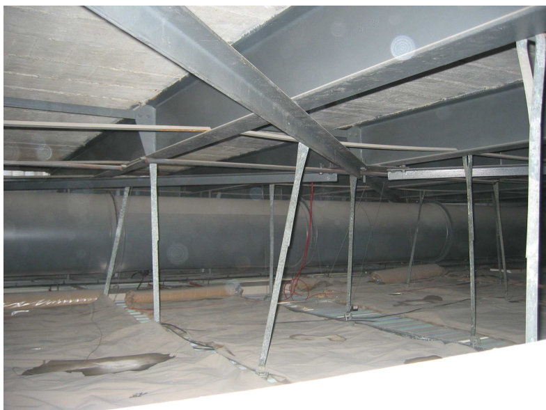
Foto 20 Nosná konstrukce galerie – válcované nosníky, zavětrování
