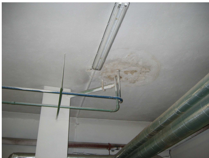
Foto 14 Vlhkost suterénu části kuchyně – v okolí prostupů technologie - kondenzace
