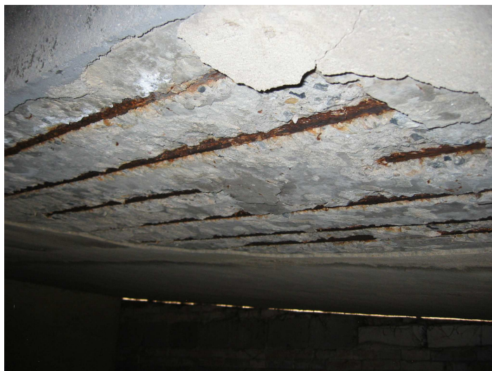
Foto 45 Koroze spodní výztuže rampy
