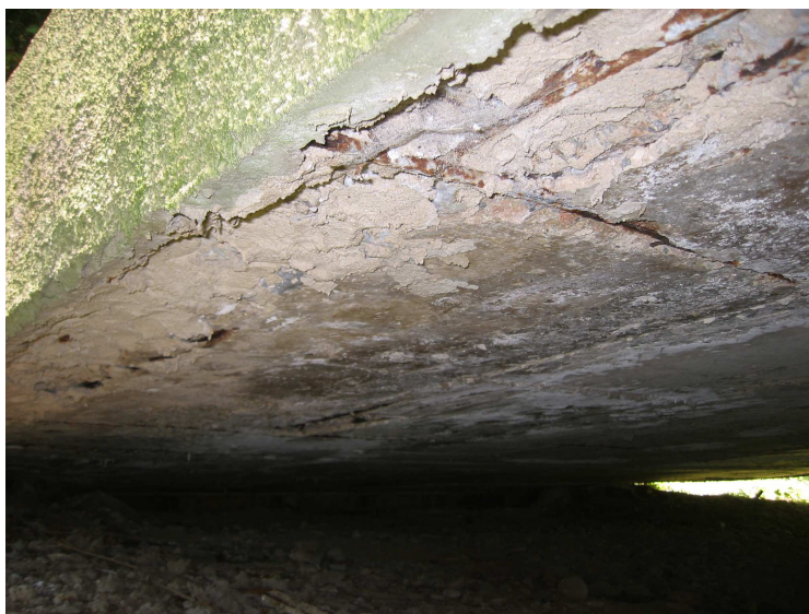
Foto 52 Stav spodního povrchu nájezdu na výstavní plochu – odpadání krycí vrstvy, koroze výztuže
