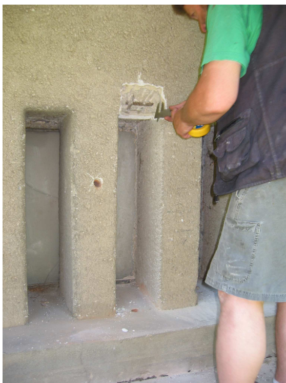
Foto 7 Architektonický prvek suterénního obvodového pláště – nadpraží železobetonové, pata a sloupky jsou zděné (ověřeno průvrty)
