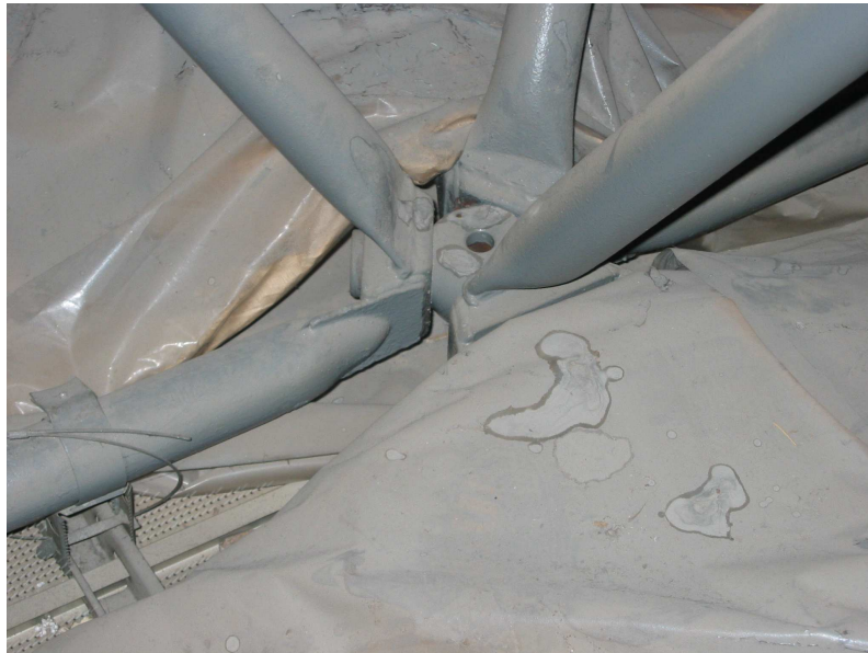
Foto 38 Detail spodního styčnicku
